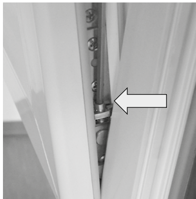
Justierung vertikal Variante a Flügel kippen. Heben und Senken des Flügels mit Inbusschlüssel SW4.
